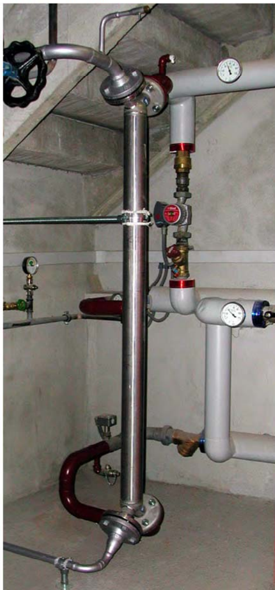
Installation en position verticale (même sous un escalier)
